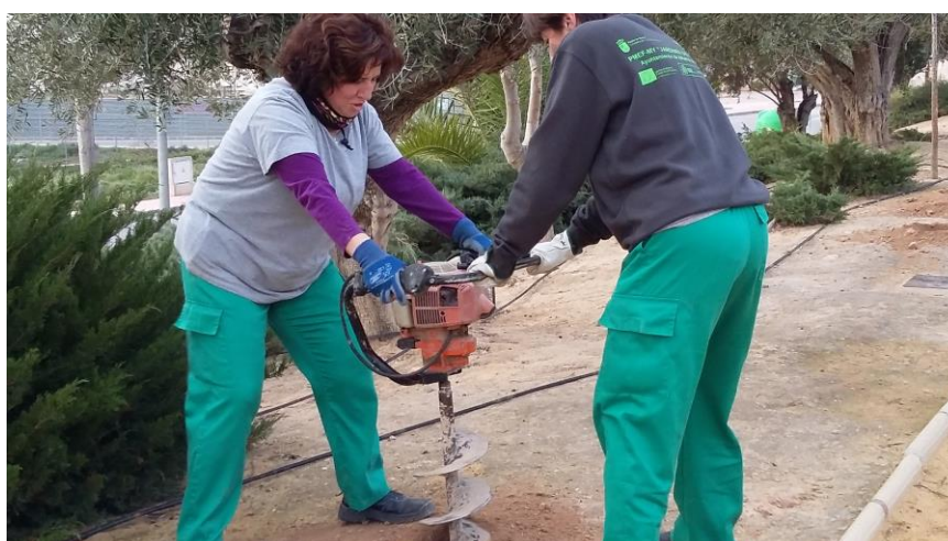
Trabajos de plantación con ahoyadora.
