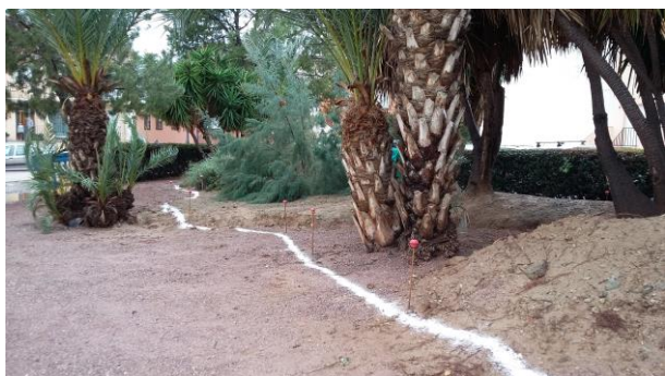
Señalización del murete para inicio de obra en parque Francisco Rabal.
