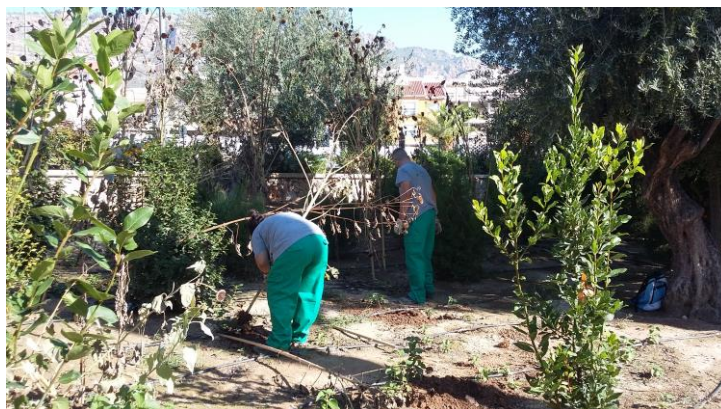
Limpieza y arreglo del sistema de riego en parque El Palmeral.
