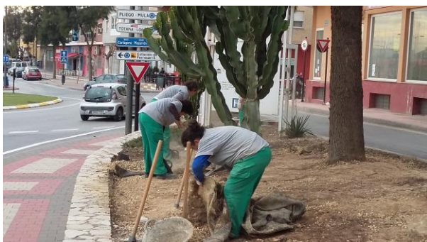
Labores de preparación del terreno en el talud Avda. Fuertes.
